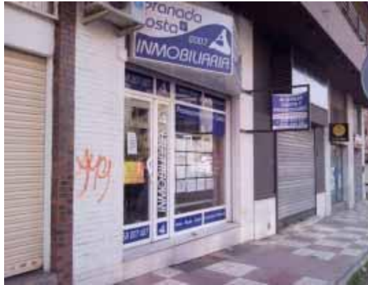
Figura 4. Diferentes edificios en una calle
