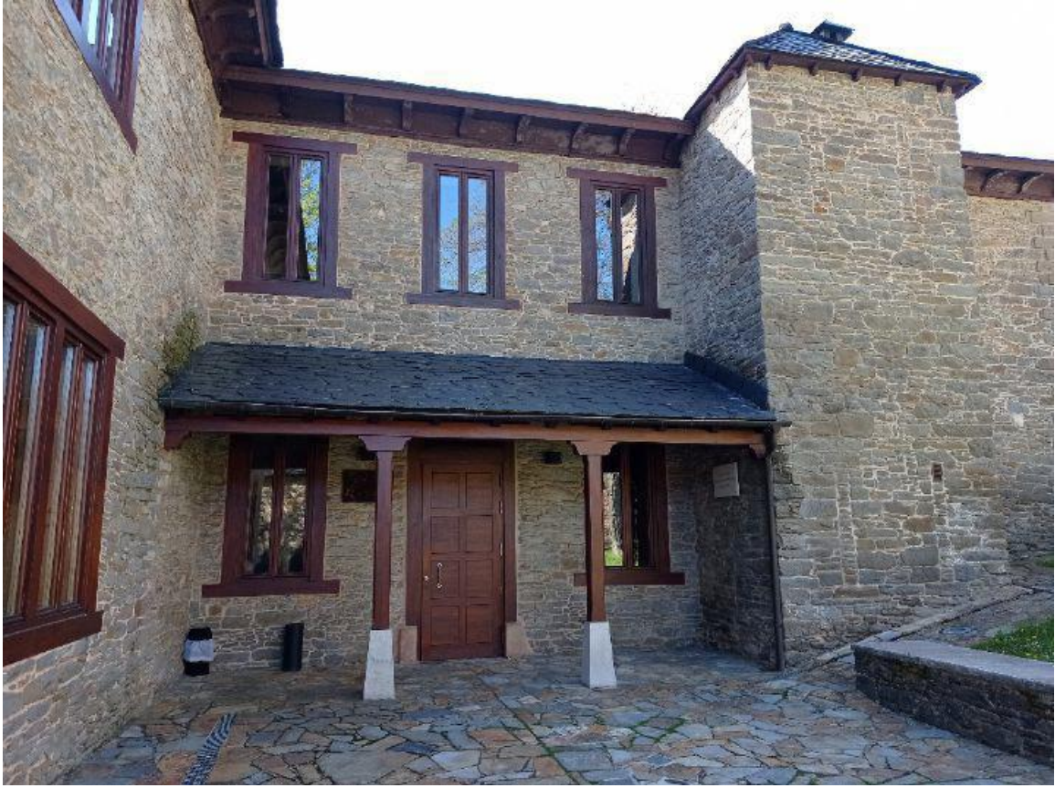
Fig. 12. Edificio de la Fundación Sierra Pambley en Villablino . Foto FRG
