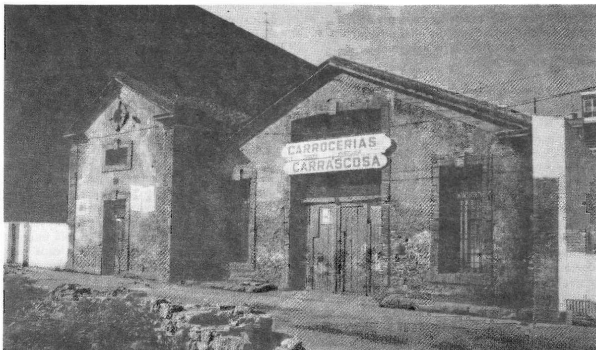
Fig. 16. Perspectiva actual de las primeras cocheras de los tranvías de Gijón, emplazadas frente a la plaza de toros, en la que se echa en falta uno de los cuerpos simétricos a la nave central, demolido para ampliar un grupo escolar contiguo.
