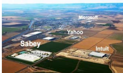
Vista aérea de los data centers de Quincy, WA
