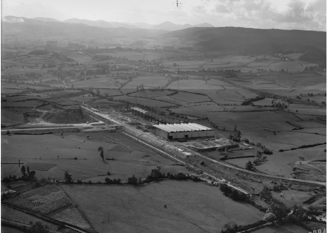
Vista aérea de la construcción del primigenio Tren de Laminación de UNINSA en 1962. Fotografía: SACE (Servicios Aéreos Comerciales Españoles). Autor: Carlos Rodríguez Escalona.
