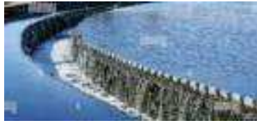
Vertedero de sedimentador de tratamiento de aguas
