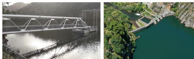
Figura 8.a. Captación de aguas; del río Narcea y el embalse de Tanes
