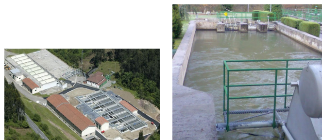
Figura 8.b. Estación ETAP Tanes y arqueta
