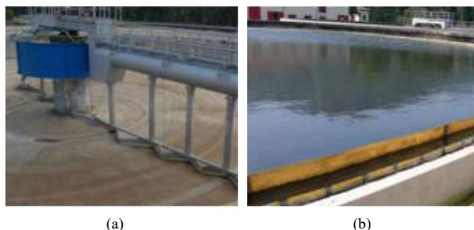
Figura 34. Sedimentador vacío (a) y lleno mostrando el vertedero (b)
