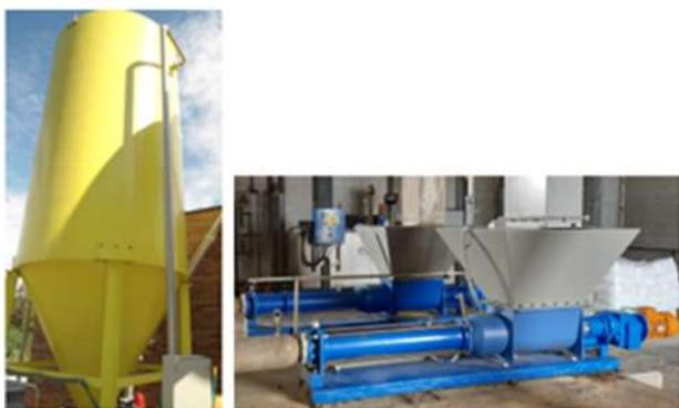
Figura 42. Depósito y bomba para fangos
