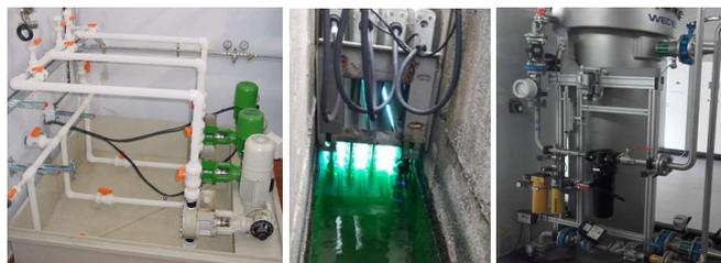
Figura 11. Cloración. Luz Ultravioleta. Ozonización
