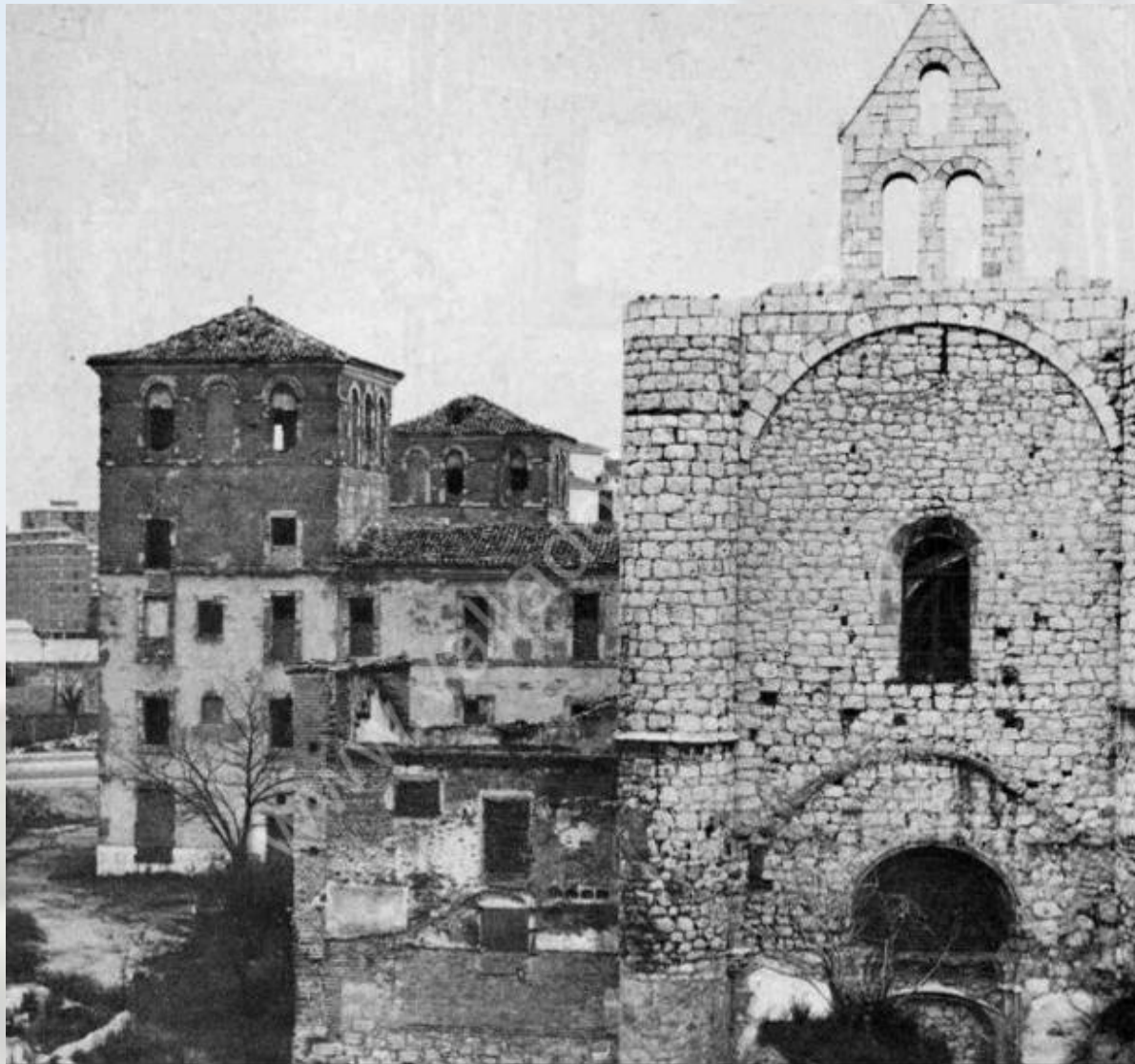
Los años pasaron y el edificio continuó abandonado, hasta que fue adquirido por la Junta de Castilla y León que lo rehabilitó completamente.
