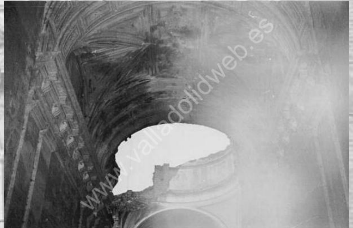
Interior de la iglesia del Monasterio de Prado hacia 1977, con la cubierta hundida.
