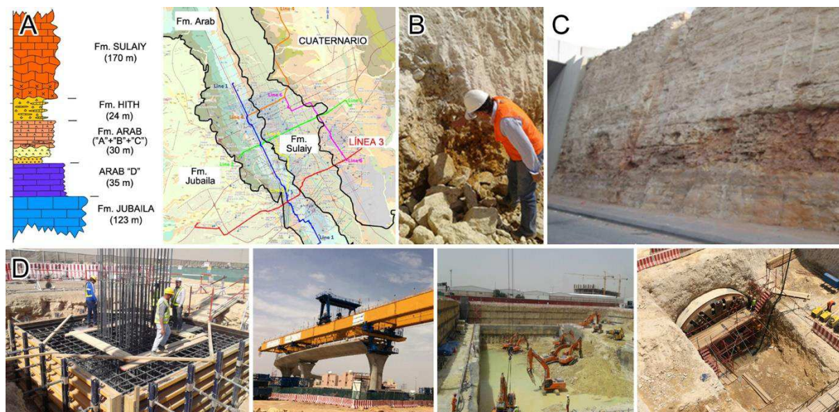
Figura 2. A) Principales unidades del subsuelo; B) Afluencia de agua en una excavación; C) Karstificación profunda; D) Imágenes de la obra (Idom, Fernando Pérez y José Ignacio Peñas).
