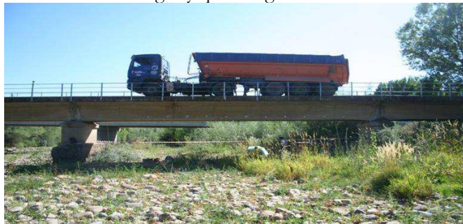
Figura 2. Puente analizado en Carbajal de la Legua (León).
