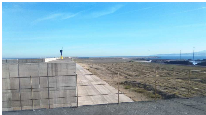
Figura 3. Zona en la que se ubicará la nueva terminal de contenedores (fuente: elaboración propia).
