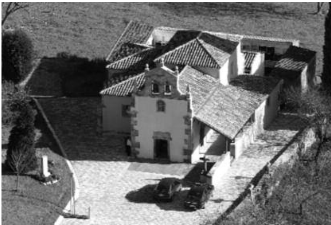
Vista aérea, tras las obras de restauración
